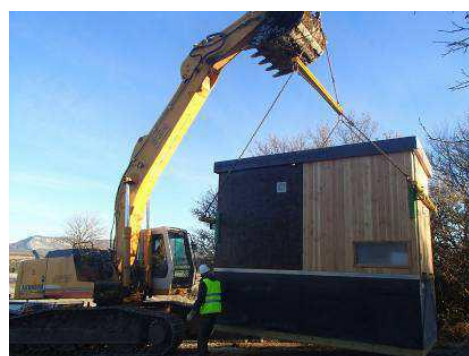
Mise en place du bâtiment © Sanisphère
