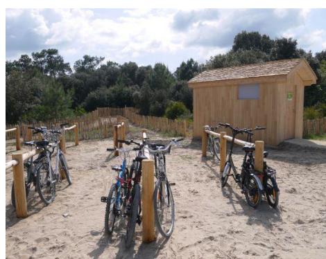
Toilette sèche autonome à lombricompostage installée Plage des Saumonard en 2019 © CdC Oléron
