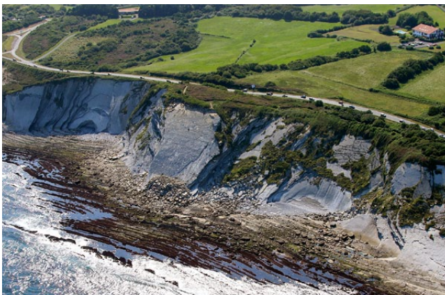
Route de la Corniche à Urrugne : repli modéré
