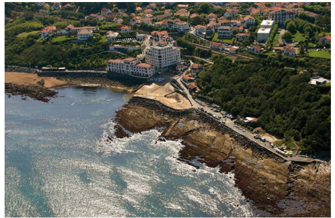
Jetée des Alcyons, Guéthary : confortement et reposition
