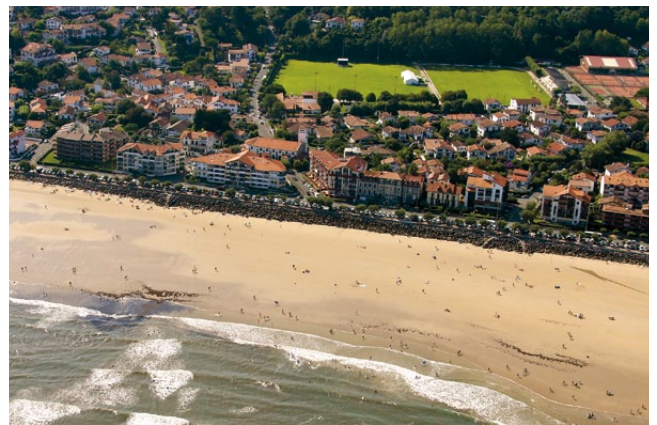
Front de mer et plage d'Hendaye : rechargements et protection
