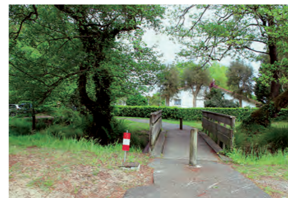
Passerelle de la Prade reliant Moïsan au bourg de Messanges
