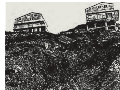
Photographies du site de la Côte des Basques, Source : Dossier de l'opération d'aménagement de la Côte des Basques, AD64 1457W40
