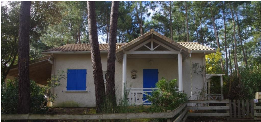
Photo 4 : Une résidence secondaire, Lacanau (Source : GIP Littoral Aquitain, 2015)
