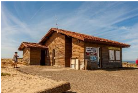
Plage centrale de Messanges, Requalification du poste de secours
