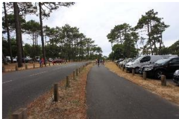
Les Casernes à Seignosse, Réalisation de la voie cyclable de connexion du plan plage à la Vélodyssée
