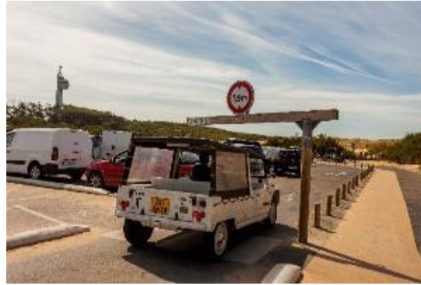
Plage centrale de Messanges, Séparation des flux et installation de portiques véhicules hors gabarit
