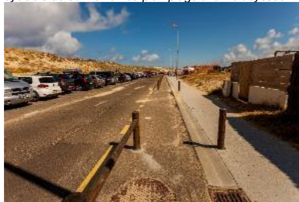
Contis, Suppression de stationnement et remplacement par cheminement piéton
