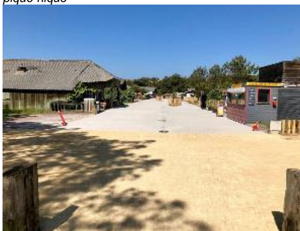
Plage du Gressier au Porge, Requalification de l'allée centrale
