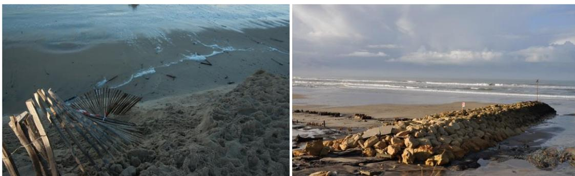
Figure 34. À gauche, chute d'une ganivelle située en haut de dune (Carcans) et à droite, dislocation de l'enracinement d'un épier à Vendays-Montalivet.
