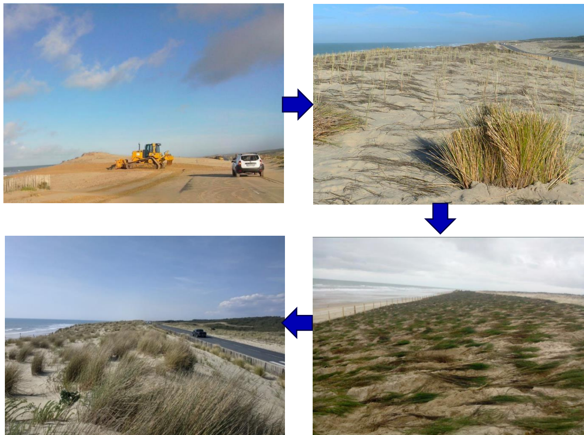
Ecrêtage de la dune, couverture de genêts, plantation d'Oyats, et photo de la dune après travaux @ONF
