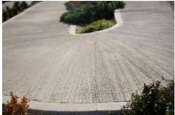
*Béton balayé : Le traitement par balayage (à l'aide d'un balai) et par striage (à l'aide d'un râteau) se fait sur le béton frais.*
