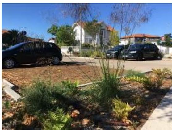
Parking de la Gare à Capbreton (Réalisation 2018) - Structure de grave ouverte sur le sable, recouverte de grès pour espace de stationnement et béton drainant aspect sable MO : C de Capbreton
