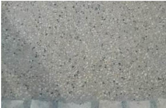
*Béton désactivé : La désactivation met à nu les granulats par enlèvement de la couche de mortier de surface. On peut jouer à l'infini sur les caractéristiques des granulats «roulés» (de rivière) ou concassés, petit ou gros, clairs ou foncés.*
