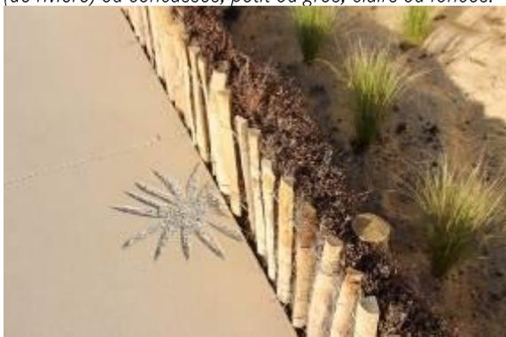
*Béton lisse et imprimé : Le procédé permet d'imprimer, au moyen d'un pochoir ou de moules, des dessins et des reliefs dans la dalle juste avant sa prise.
