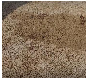
*Réaménagement de la rue du stade à Azur (40) - Réalisation d'une chaussée en enrobés drainant et d'un trottoir en béton drainant clair - MO : C d'Azur et CdC MACS. Objectifs : s'affranchir du réseau d'évacuation des eaux pluviales*
