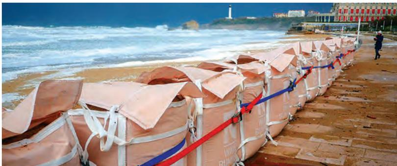
Un suivi rapproché des prévisions météo-marines est réalisé en continu par la commune et des actions de protection temporaires (type pose de « big bags » sur le front de mer) sont déclenchées en cas d'alerte vague-submersion.
