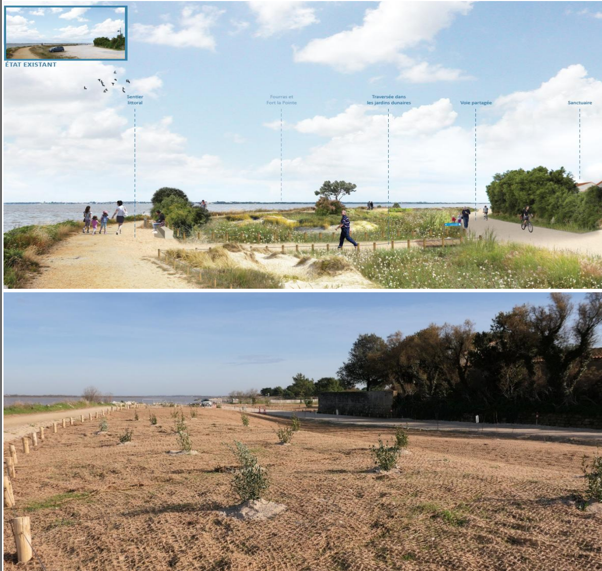
Pointe du Calvaire, Port-des-Barques - Travaux réalisés en 2025-2026
