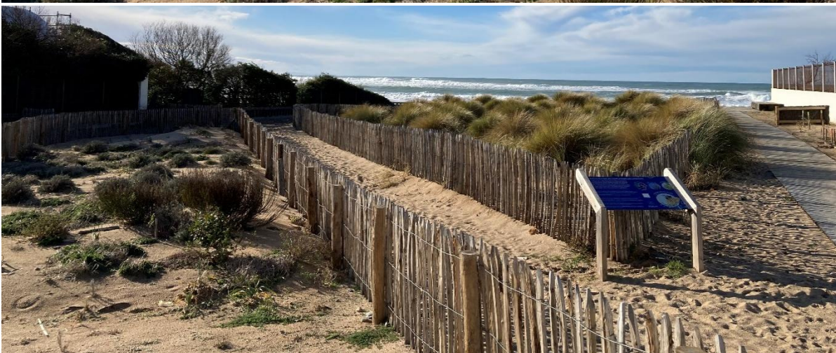
Plaine de l'Uhabia, Bidart - Travaux réalisés en 2023
