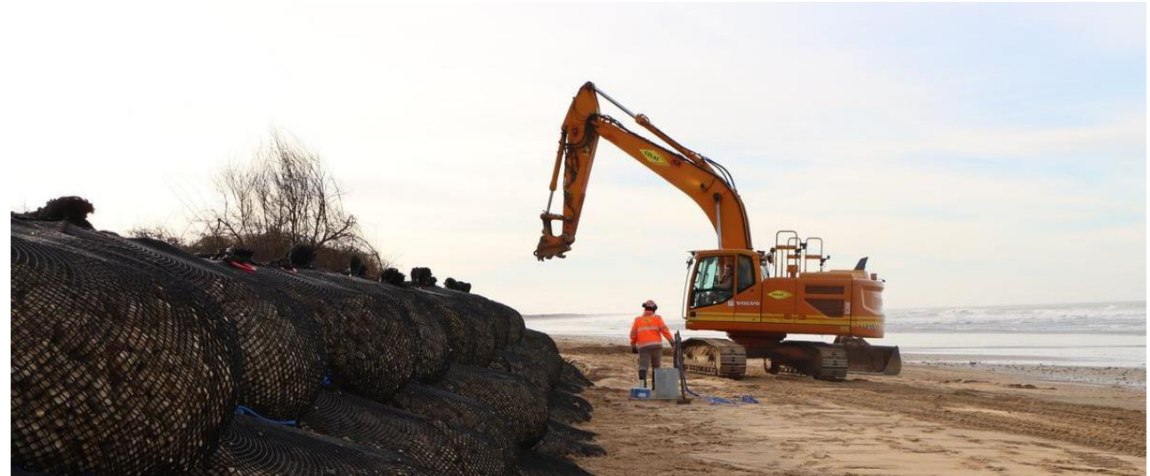
Pose de gabions souple sur le Trillou - Grand-Village-Plage - 2026
