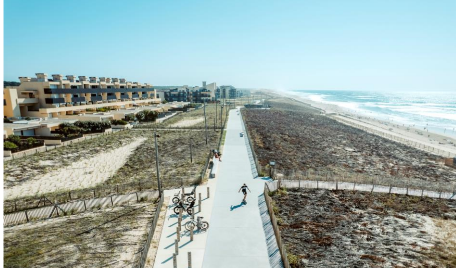
Renaturation de la promenade Sud à Lacanau – Travaux 2025 Désimperméabilisation de 8000m 2 / suppression des dalles béton et espèces envahissantes
