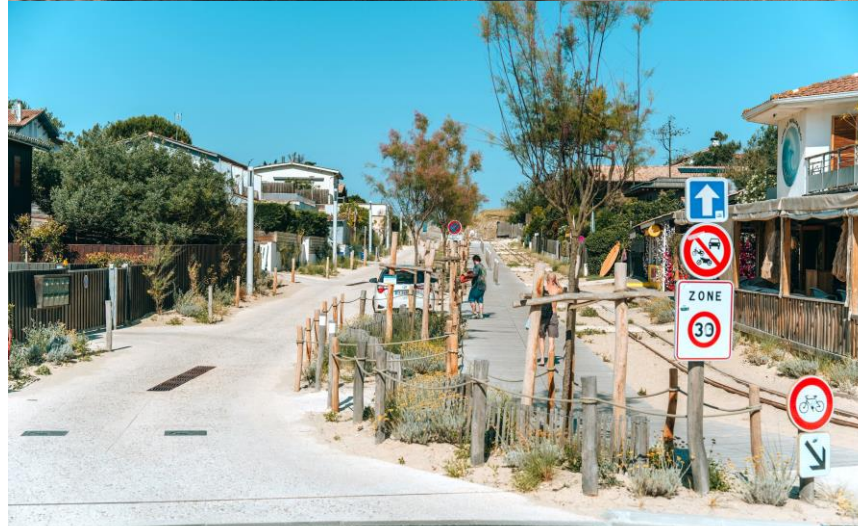
Traitement de voirie accès Plage de l'Horizon à Lège Cap Ferret – Travaux 2024 Désimperméabilisation de 1350 m 2
