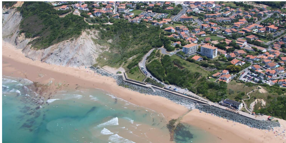
Travaux confortement Plage du centre – Bidart 2025/2026
